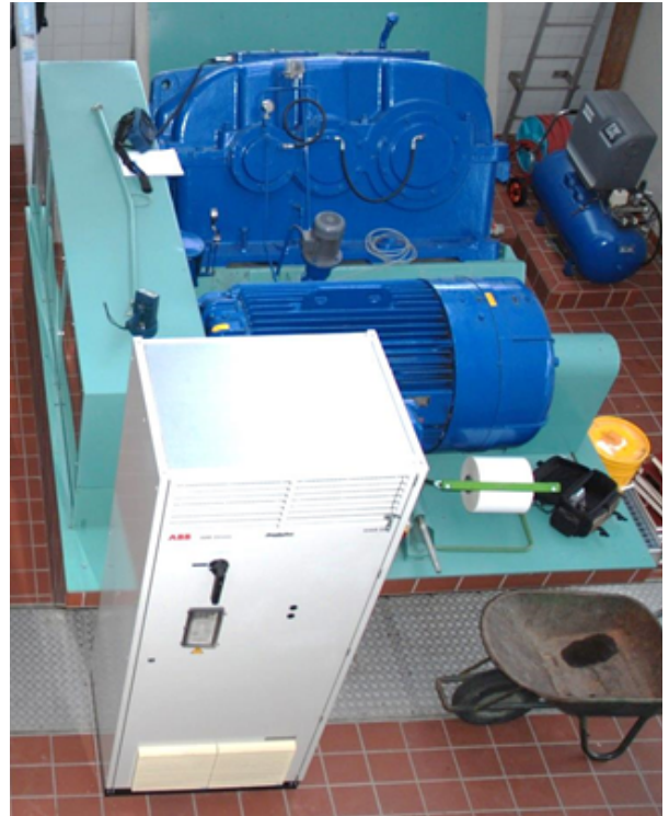
Figuur 1 Frequentiegestuurde vijzelaandrijving
