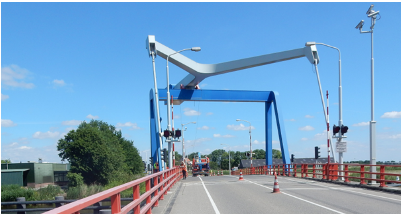
Figuur 1 Traagdraaiende lagers van een brug
